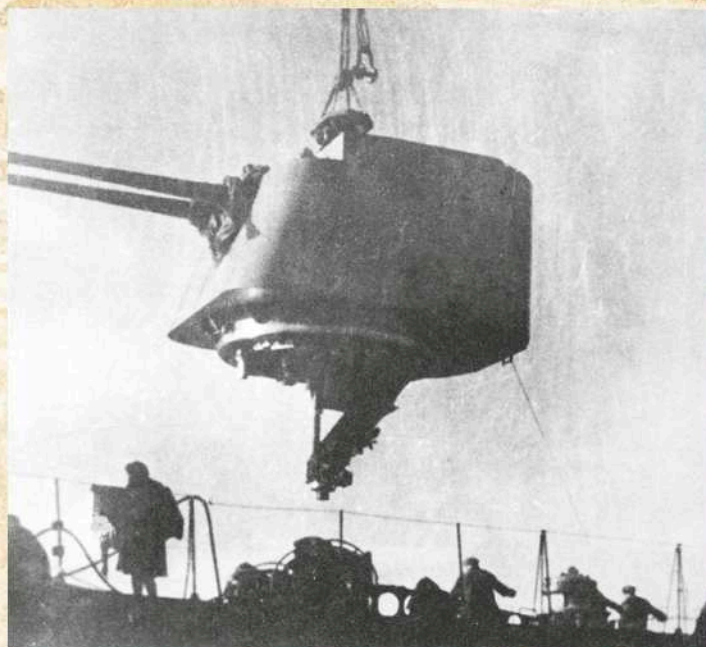
Завод № 402. Погрузка орудия на эсминец проекта 30. 1944 г.
